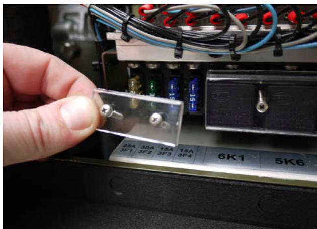
3. Mithilfe eines Sicherungsabziehers die Sicherung entfernen und durch eine neue ersetzen.
